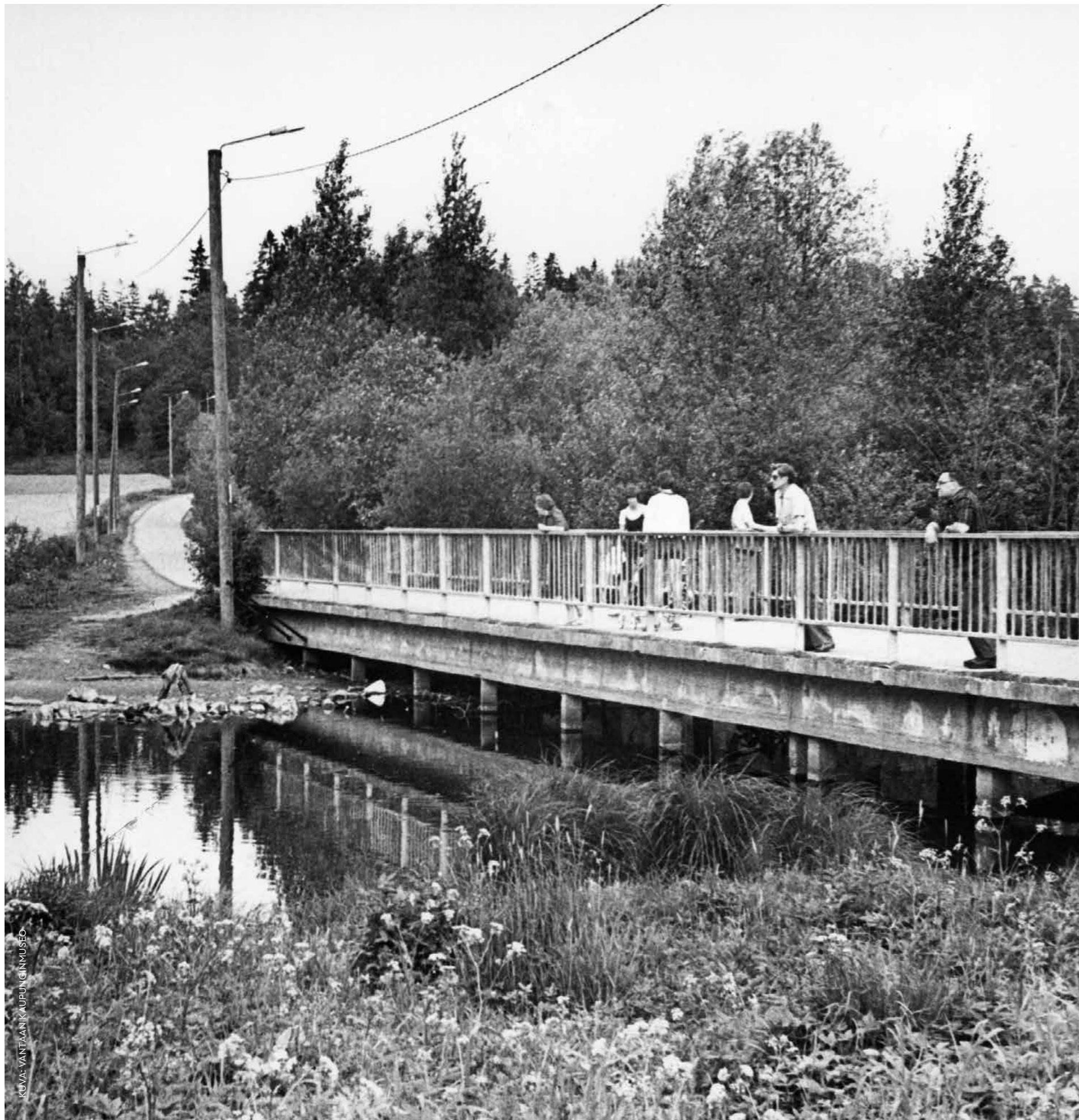
Mätäojan ylittävä silta Louhelassa noin 1980.
