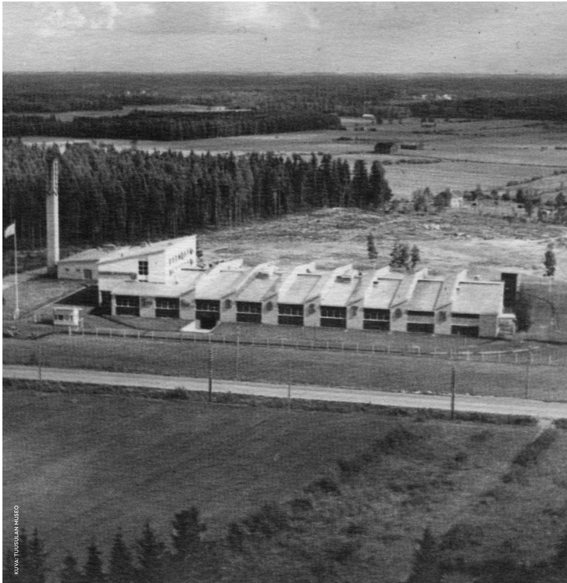
Amer-Tupakan tehdasrakennus valmistui loppuvuodesta 1955.
