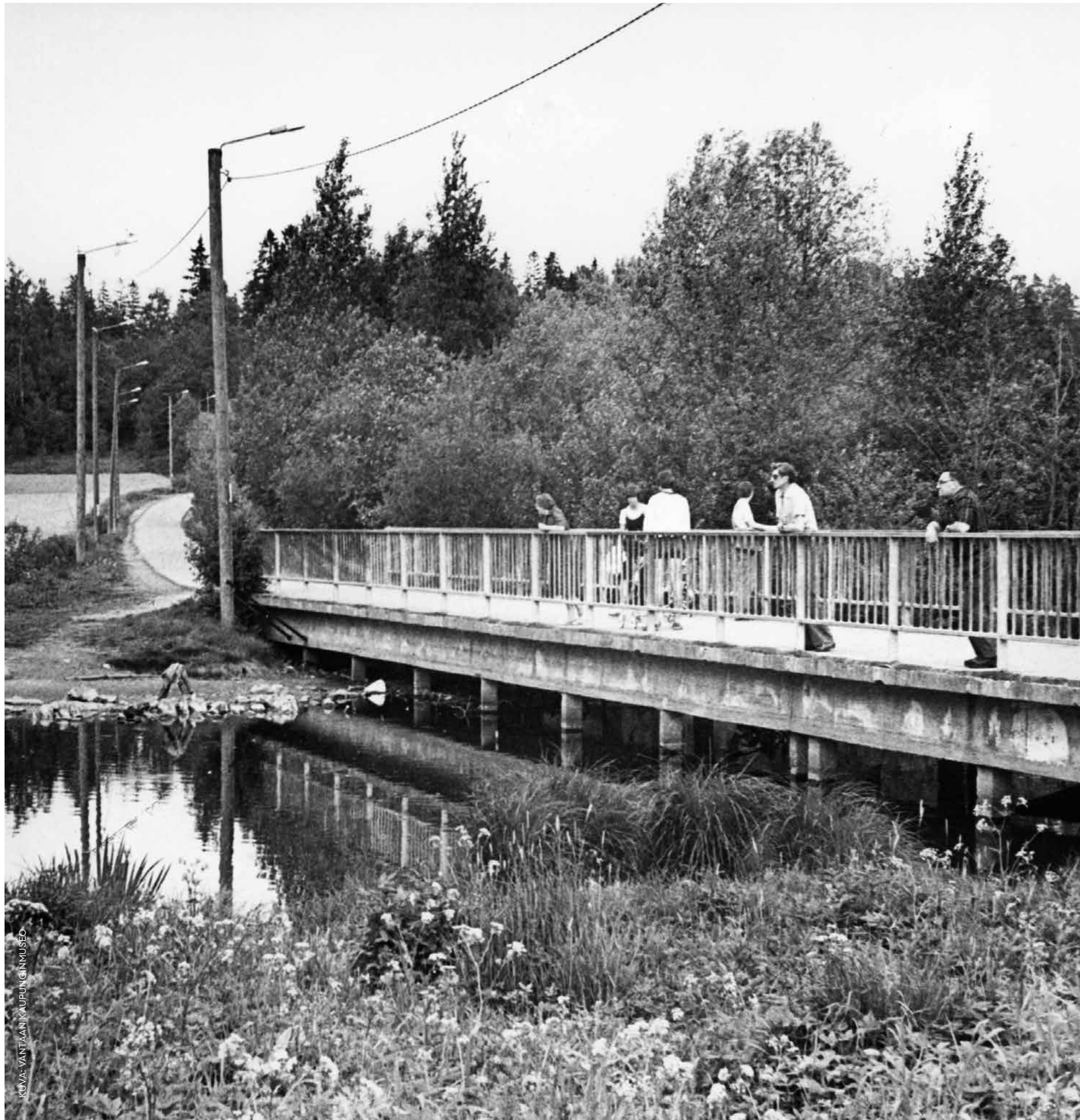
Mätäojan ylittävä silta Louhelassa noin 1980.
