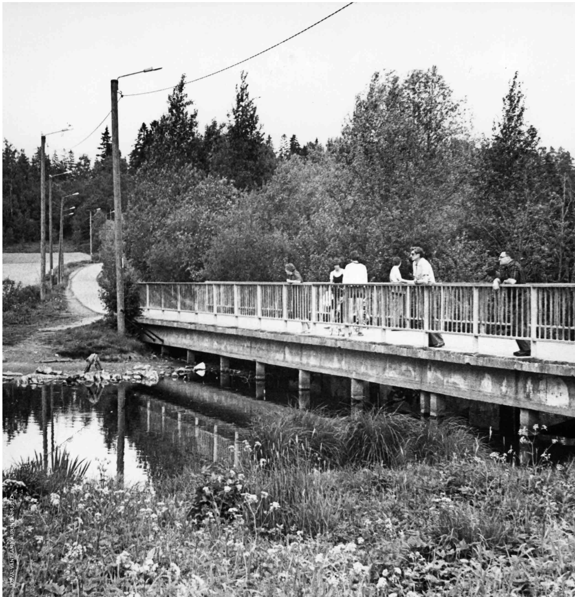
Mätäjojan ylittävä silta Louhelassa noin 1980.
